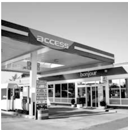
„Die Tankstelle“ der Familie Eckendörfer nach der Modernisierung 2018
