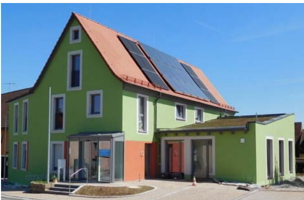
Photovoltaik-Modul. Die Dachränder sollten auf mind. 0,60 m frei bleiben, damit das Dach als Bauteil noch erkannt wird.
