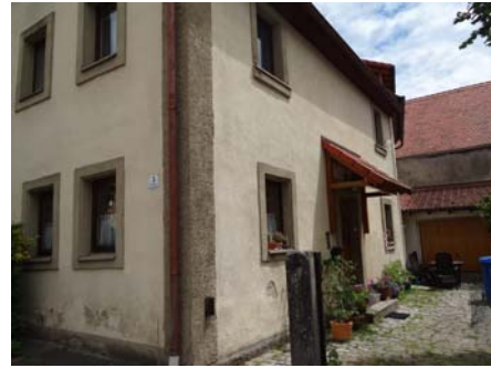
Ecklisene und Fenstergewände
