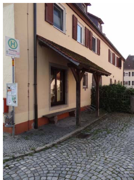
Vordach zum Unterstellen an der Bushaltestelle
