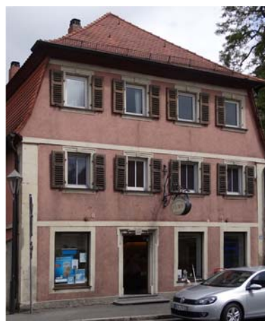
Fassade und Fenster passen nicht zusammen. Eine bessere Einbindung neuer kleinerer Schaufenster mit stehenden Format wertet das Gesamtgebäude auf.
