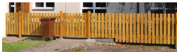
Handwerklich gut gestaltete Tor und Pforte. Alles handwerklich hergestellt. Drehpfosten in einer Fußpfanne als funktionale Lösung. Die später ergänzten maschinell gestanzten Blüten sind zu viel.
