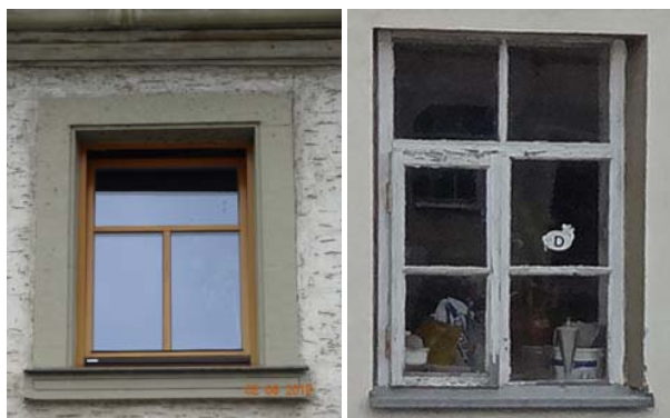
Modernes dreigeteiltes Holzfenster mit Sandsteingewände links.
