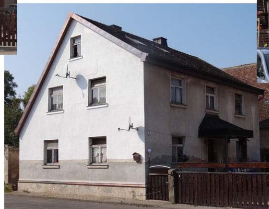
Eineinhalbgeschossig mit Frackdach
