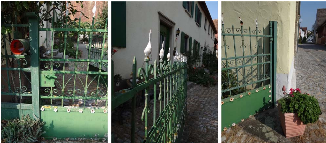
Handwerklich gut gestaltete Tor und Pforte. Alles handwerklich hergestellt. Drehpfosten in einer Fußpfanne als funktionale Lösung. Die später ergänzten maschinell gestanzten Blüten sind zu viel.
