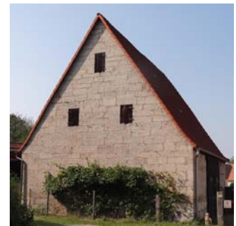
Sandstein steinsichtig vermauert bei Scheunen u.a. Nebengebäuden. Auf den Kalkfugenmörtel, farblich abgestimmt und genauso hart wie der Sandstein, kommt es an!
